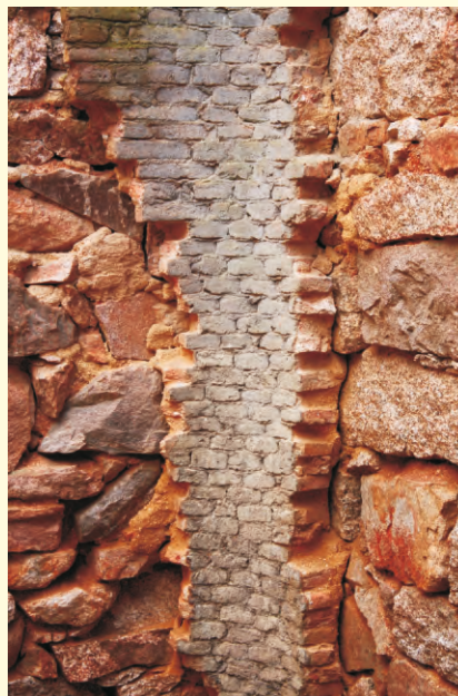
Detalle da vestidura interior do forno.
