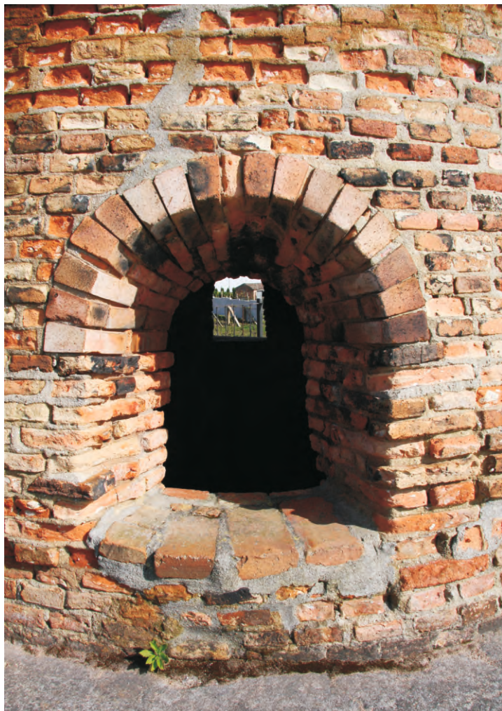
Cheminea da tellera de Dena: ladrillos de cuña.
