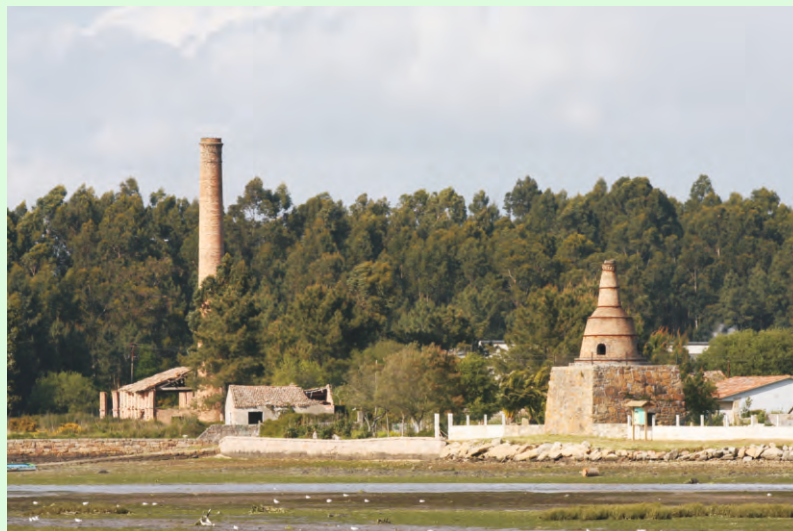
Vista actual da Telleira de Noia. Ao fondo a cheminea da telleira de Villaverde. Desde Dena hai un paseo ata a telleira con paneis informativos.
